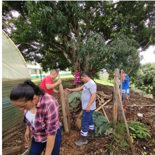
Ilustración 38 Taller Construcción Germinador
